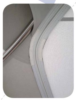
Reißverschlüsse im Bogenbereich müssen eingeschnitten werden und werden von uns gesondert abgedeckt.
